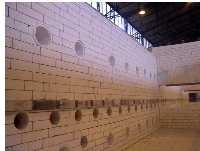
Футеровка печей и камер
